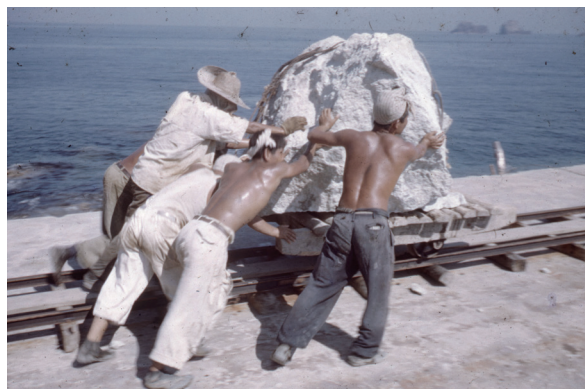
写真15 沖ノ島港湾工事 (1954.5)
