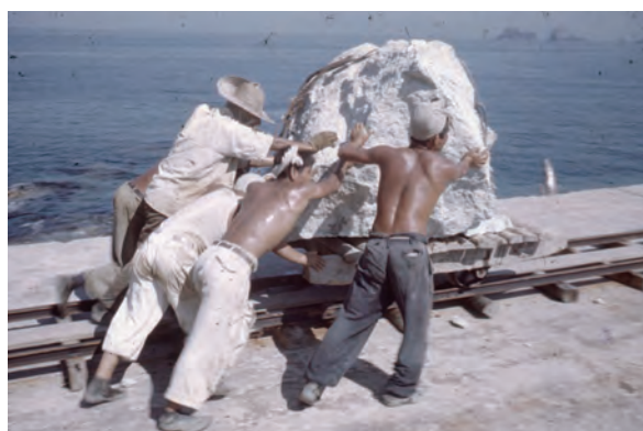
写真15 沖ノ島港湾工事 (1954.5)
