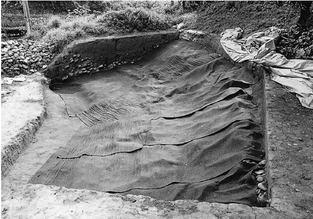
第2図 第1・8・10トレンチ底に敷いた透水シート
