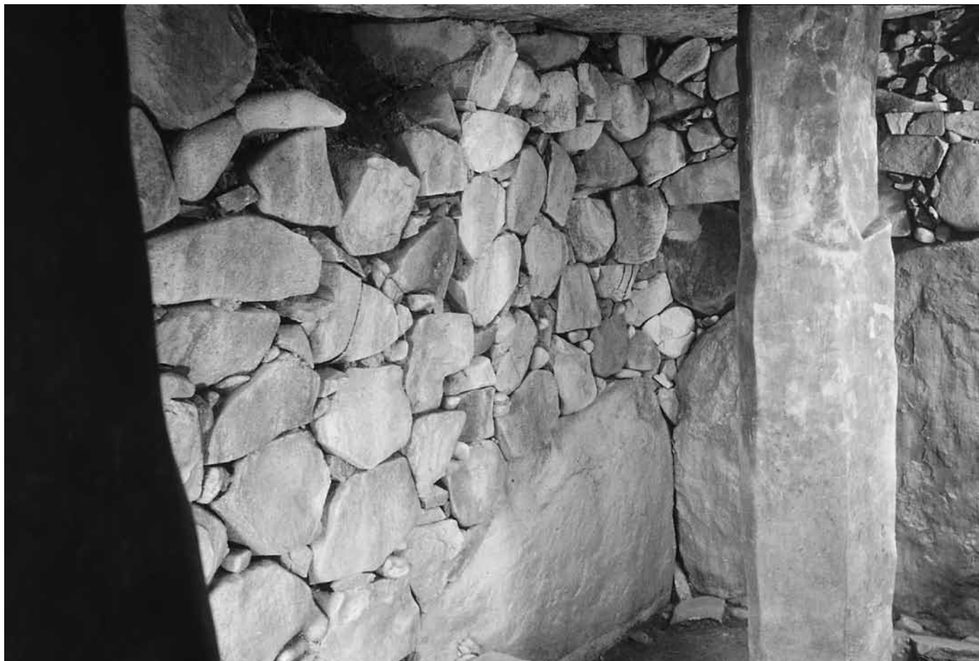
1. 左側壁・奥壁側（南から）
