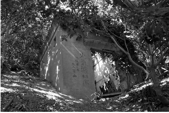
写真1 土石採取に関連する施設
