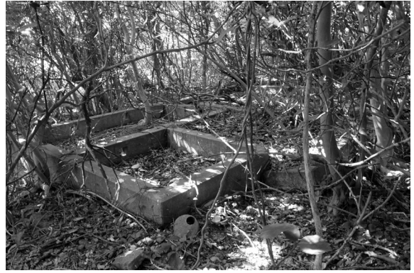
写真9 海軍施設(建物基礎)
