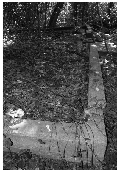
写真5 防備衛所(建物基礎)
