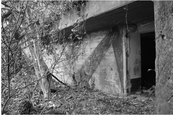
写真 11 西上弾薬庫外観
