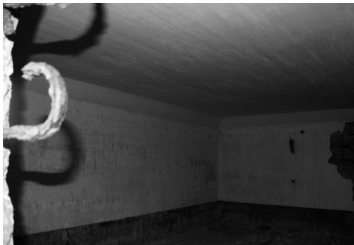
写真20 東側弾薬庫内部
